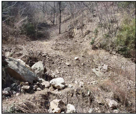
PD1硐口堆渣现状
