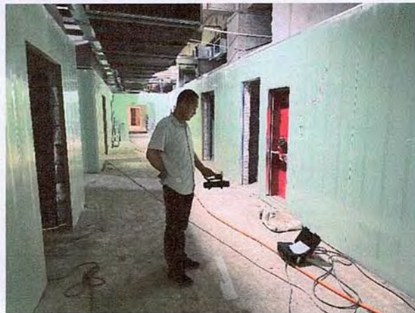
拟建 DSA 手术室东侧洁净走廊
