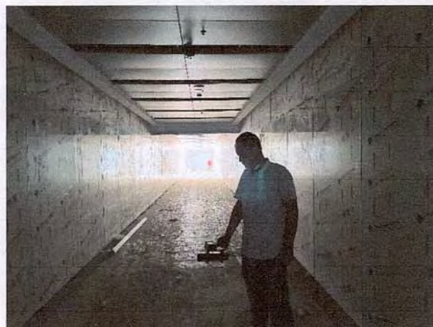
拟建 DSA 手术室楼下走廊
