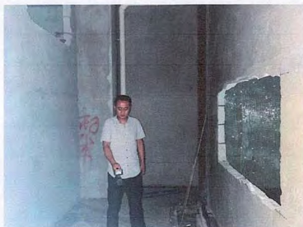
拟建 DSA 手术室南侧控制室
