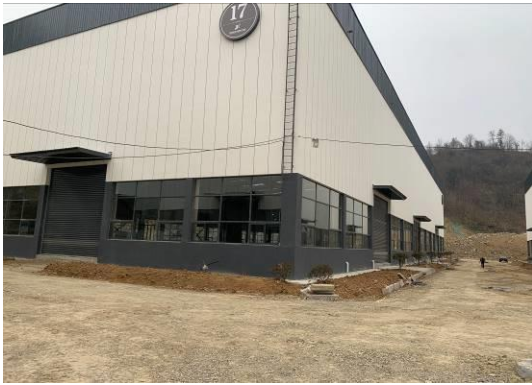
商南县现代材料产业园 17 号厂房
