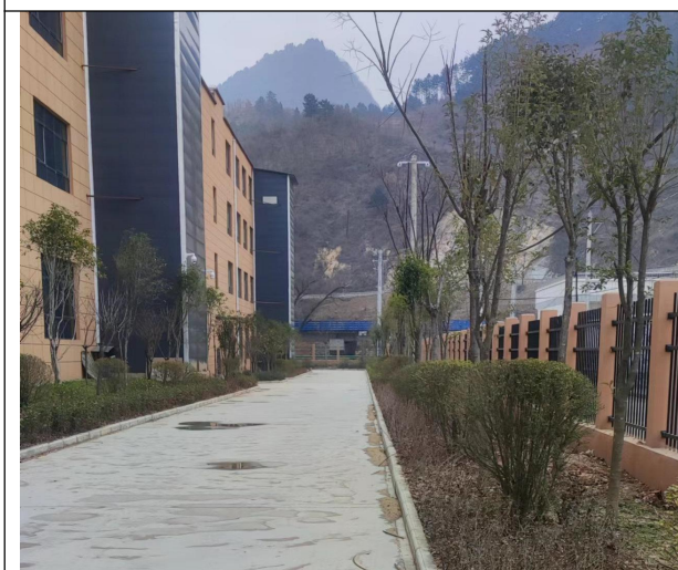
项目西侧园区道路
