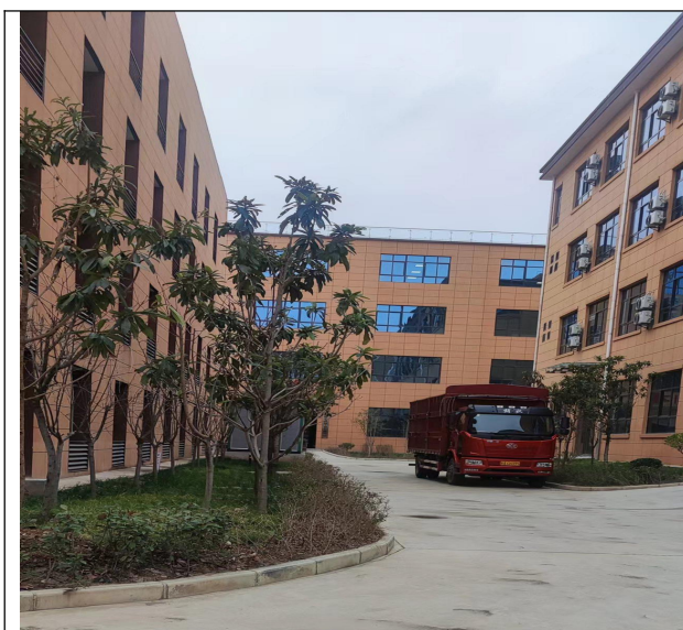
项目东侧厂房
