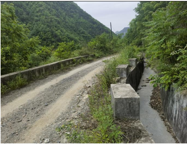
尾矿库西侧挡水墙、道路、雨水渠
