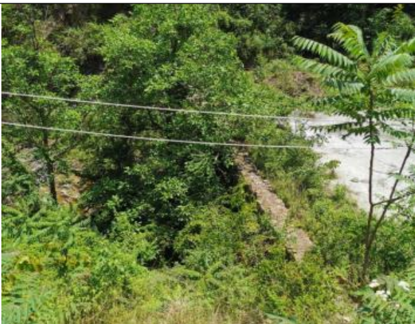
尾矿库上游土石挡体
