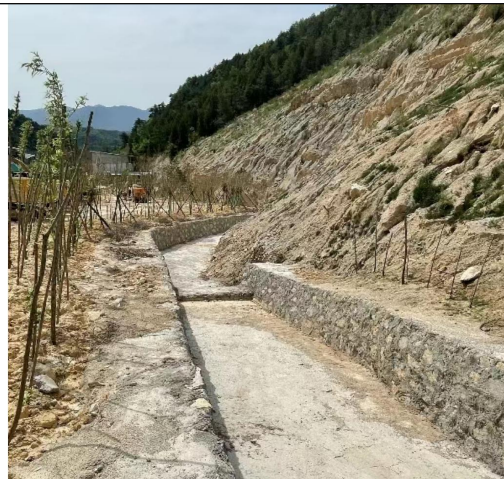
排水沟及生态恢复
