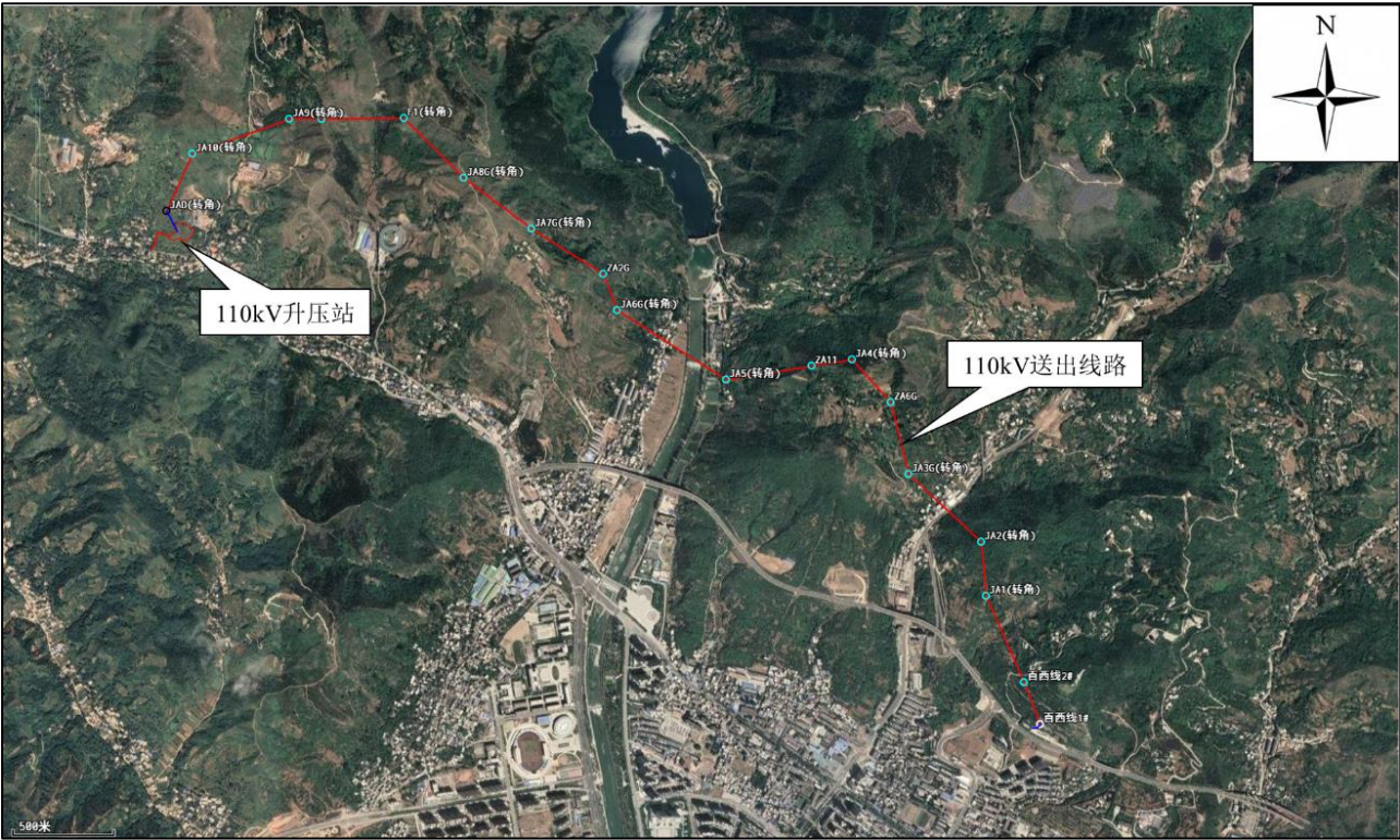
图1-2 110kV升压站与110kV送出线路概况
