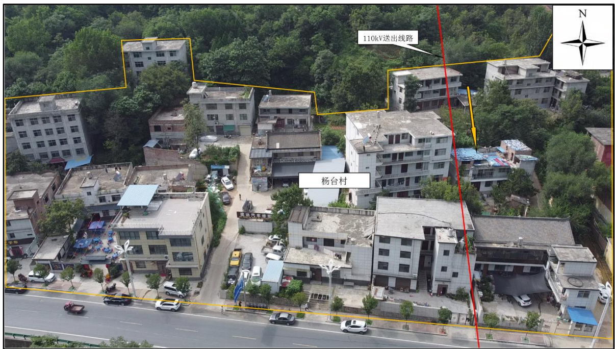
图 3-8 本项目送出线路穿越舍家河村的穿越情况
