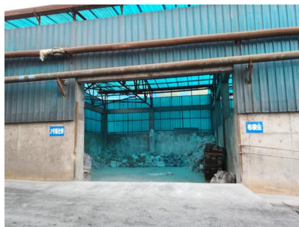
周转渣库（共分为 7 个库，位于厂区浸出渣干渣库西侧，封闭）
